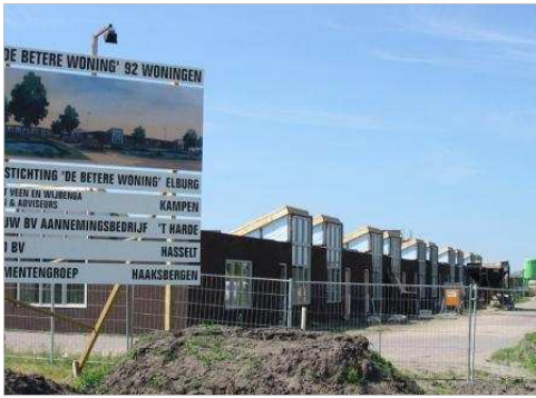
Multifunctionele woningen van DBW in aanbouw in De Pal (Elburg)
